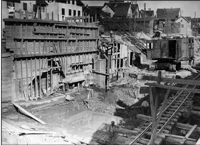
Abb. 18: Bau der Spundwände. Fotoalbum Remsverbesserung Waiblingen. 1. Bauteil. Seite 18. StA Waiblingen FS3-
