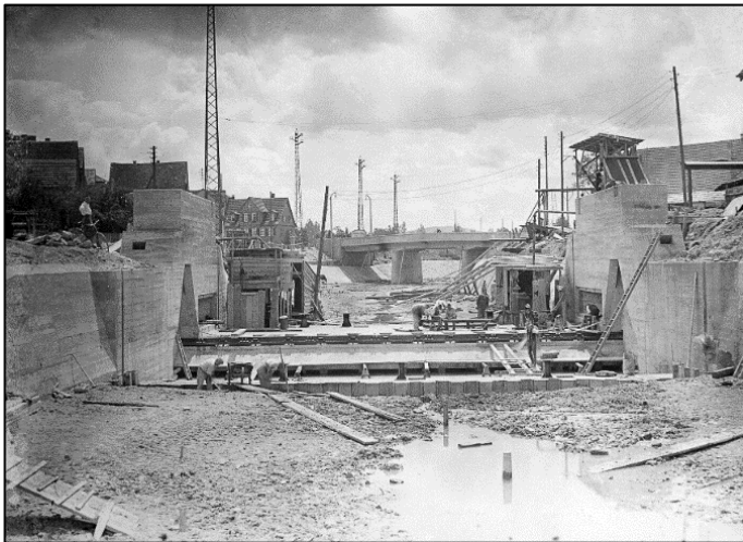
Abb. 19: Bauarbeiten am neuen Wehr. Fotoalbum Remsverbesserung Waiblingen. 1. Bauteil. Seite 16. StA Waiblingen, FS3-
