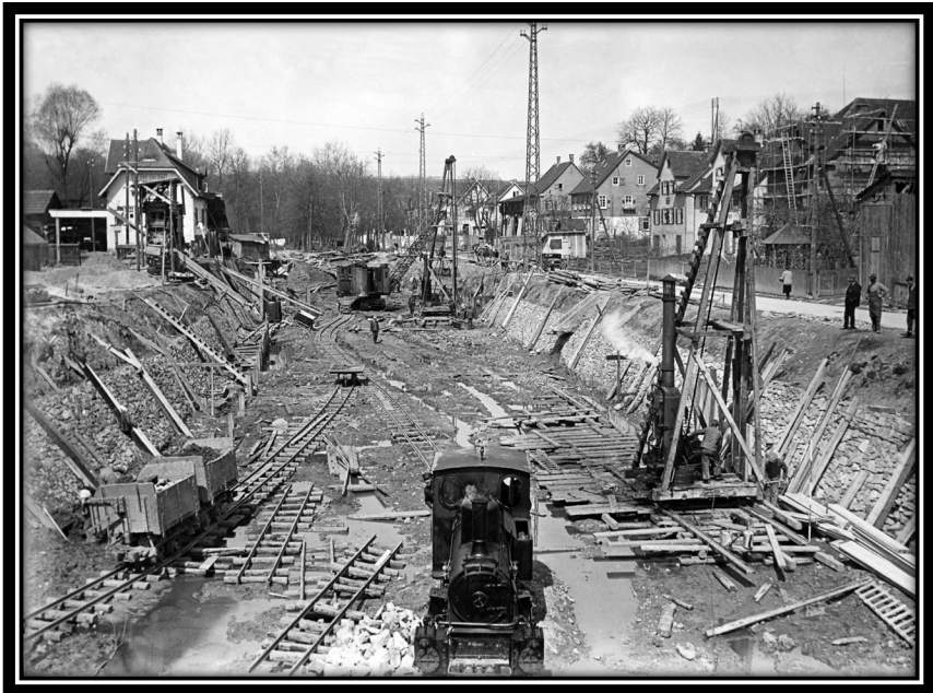
Abb. 1: Bauarbeiten an der Rems 1932, StA Waiblingen FS3-1
