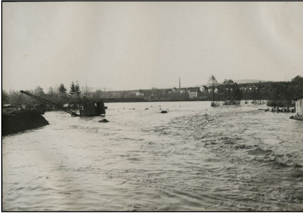
Abb. 16: Hochwasser vom 7. Mai 1931 oberhalb der neuen Straßenbrücke. Fotoalbum Remsverbesserung, Seite 4. StA Waiblingen FS3-1
