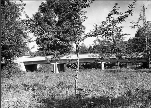
Abb. 23: Rechter Remsarm oberhalb der Brücke vor der Verbesserung, StA Waiblingen FS3-1, Seite 6
